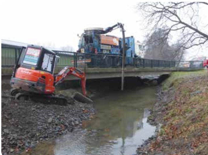
Čištění koryta potoka
