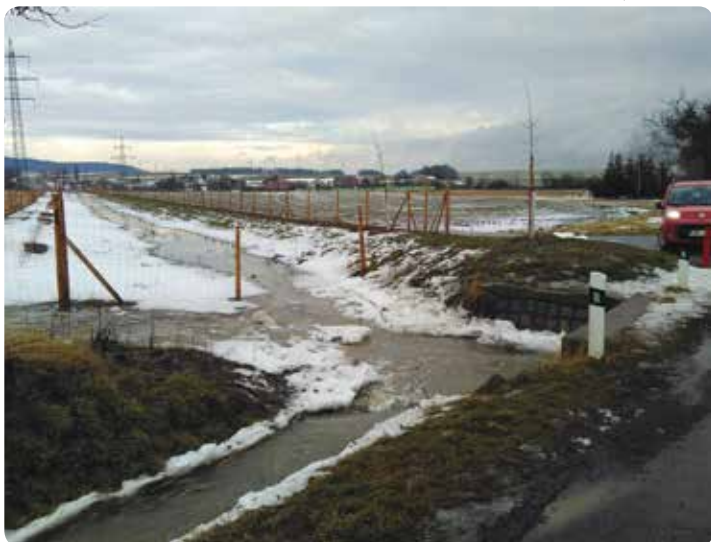
Protipovodňový průleh při tání sněhu
