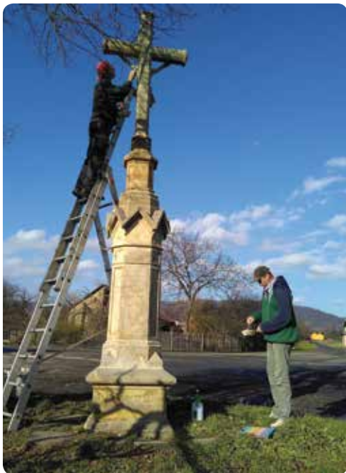
Oprava kříže v Agrochovu
